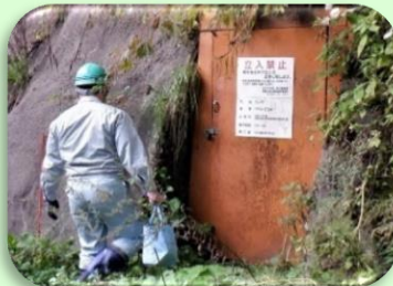
調査横坑入口
